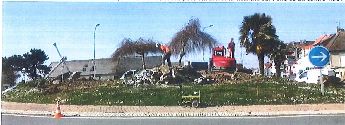
Travaux d'arasement de la butte du giratoire du pont rose pour améliorer la visibilité sur l'entrée du centre-ville :
