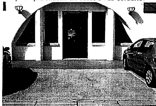
Photo du trottoir rabaissé pour que chacun ait accès à «La Corderie»
