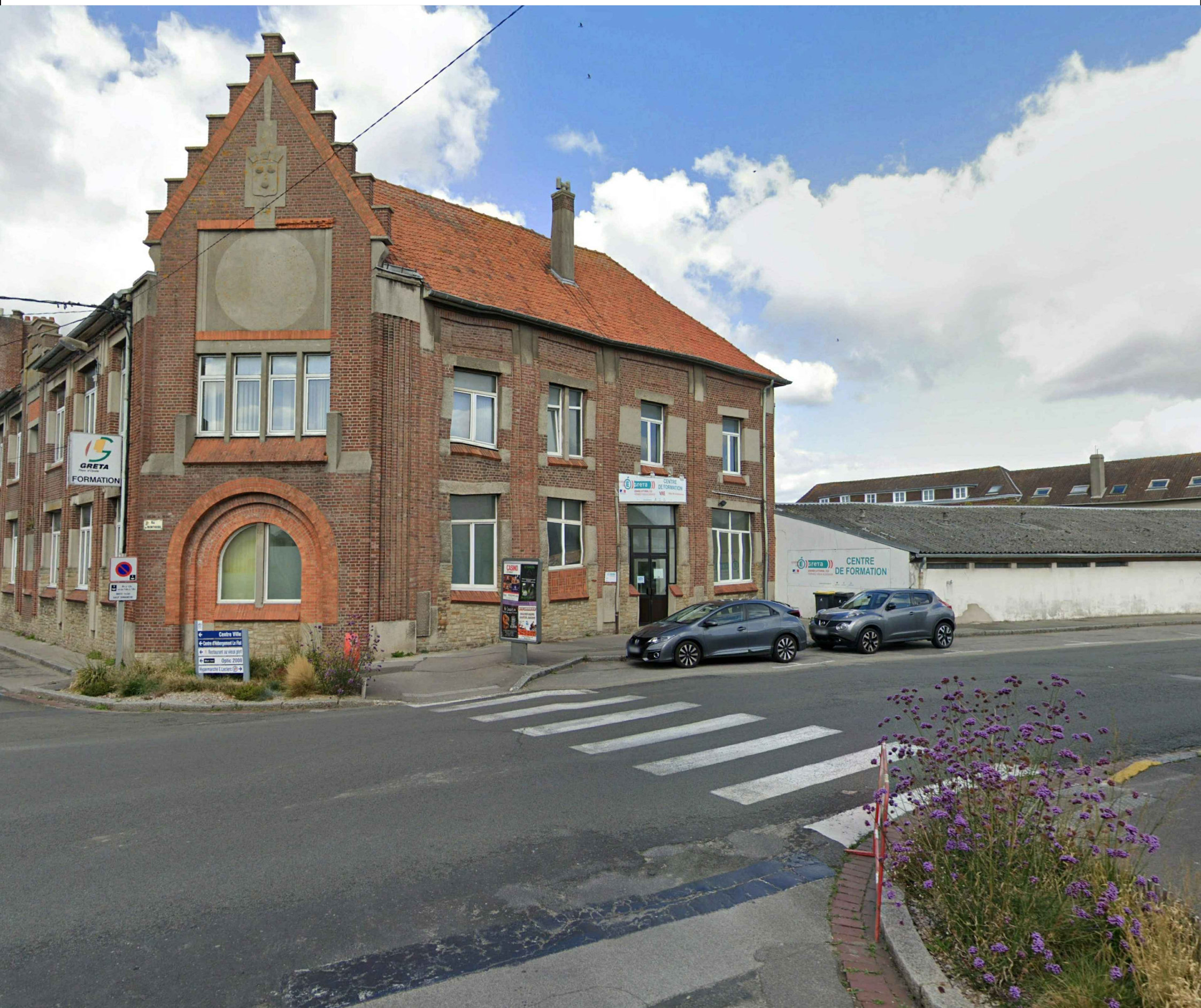
5 - Vue existante depuis la rue de Montreuil
