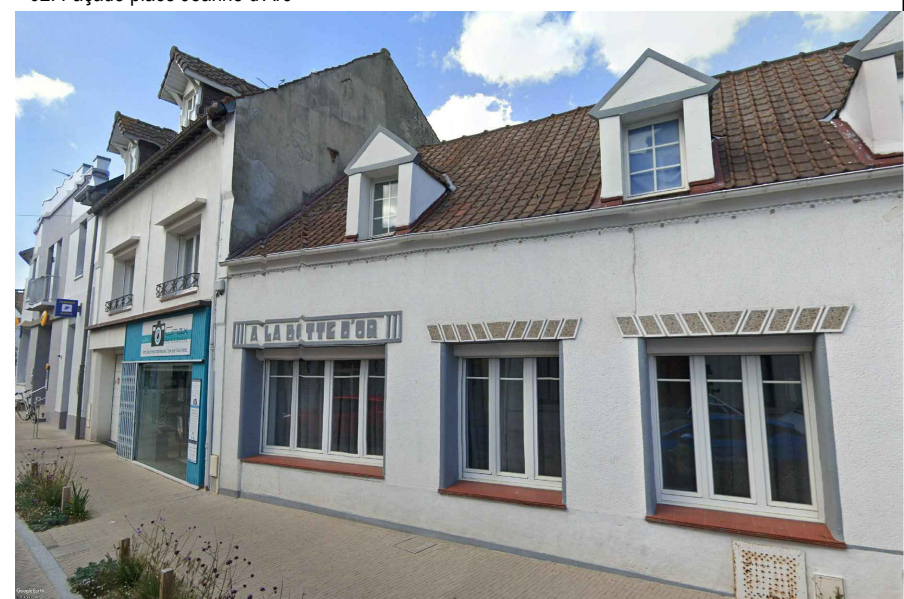
- 03. Façade rue du général Obert -
