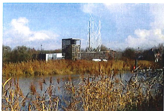
Centre de découverte de l'estuaire de la Loire Port de Cordemais, Nantes
